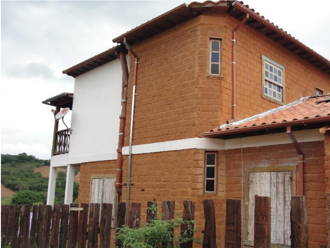
Figura 5. Construção em adobe aparente, Bichinho (MG). Fonte: VALE (2012).
