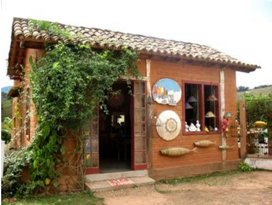
Figura 3. Construção em adobe aparente em Bichinho (MG). Fonte: VALE (2012).
